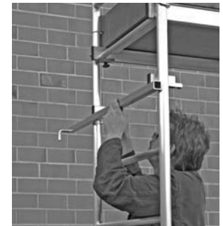
Grundgerüst mit erster und zweiter Aufstockung
